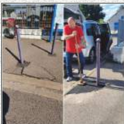
Réparation d'un potelet dégradé par un véhicule.
