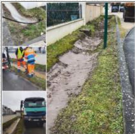
Un entretien par curage et hydrocurage a été réalisé dans tous les fossés du lotissement du chêne brûlé.
