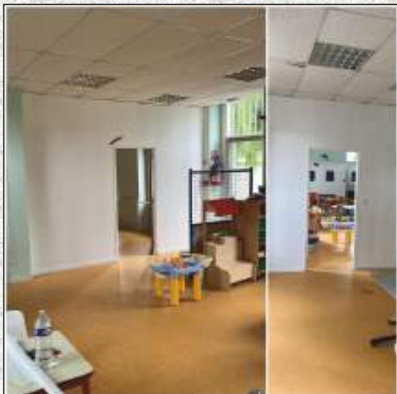
Suite au changement de locaux entre l'école maternelle et le périscolaire, la grande pièce côté périscolaire a été divisée en 2 afin de créer un espace dortoir.
